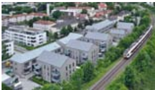
Letzter Abschnitt im Bau
