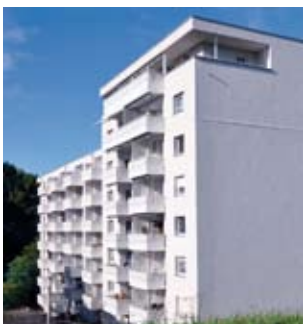
Aufgestockte Häuser Salzertstraße 59 - 63
