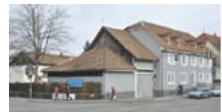
Mättle vor dem Umbau
