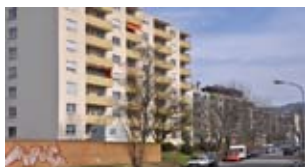
Leibnizweg 5 + 6 vor der Sanierung, vorne links das alte Parkdeck
