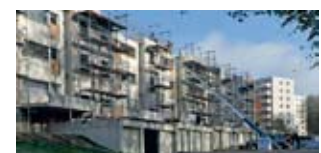
Salzertstraße 41 bis 45 vor der Sanierung und während dem Umbau
