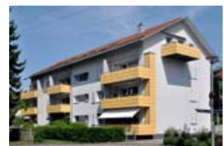
Die Gebäude Karlsbader Straße 18 - 20 (oben) und Jahnstraße 17 (unten) wurden saniert und in Wohnungseigentum umgewandelt.
